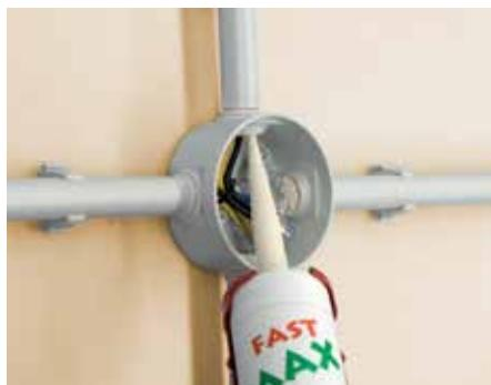
Se non si usano pressacavi, chiudere tutti i passaggi dei cavi con un sigillante, per evitare la dispersione del prodotto
